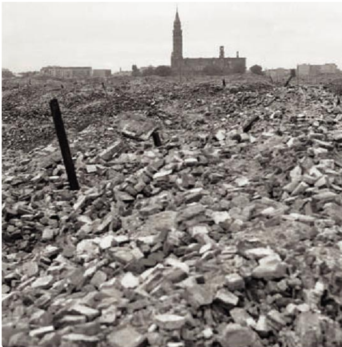
Ruiny warszawskiego getta (1943). Po stłumieniu powstania Niemcy wysadzili w powietrze ocalałe budynki.
